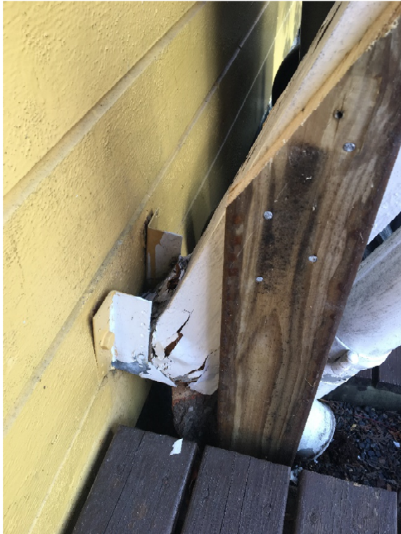
Fig. 4: Midlertidig «sikring» påført før kollaps av bjelke, i påvente av utskifting
