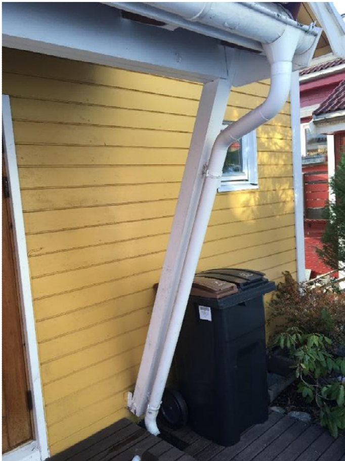
Fig 1. Støtte pilar/bjelke til tak over inngangsparti
