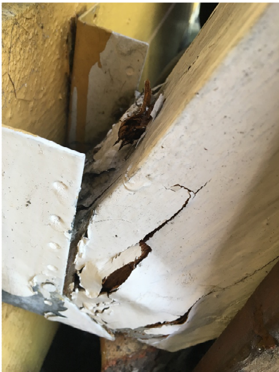
Figur 3: Kollaps av bjelke etter råtne i nedre del
