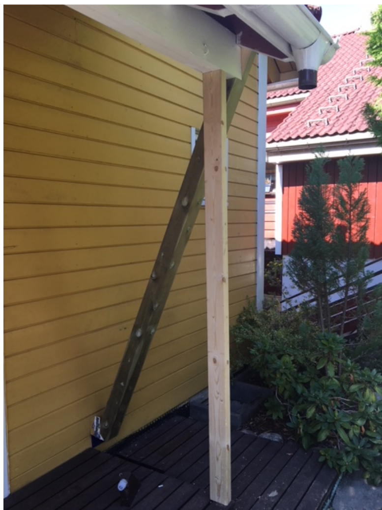
Figur 5; utskiftet stolpe av trykkimpregnert type med midlertidig støtte, og plastplate mot bordkledning
