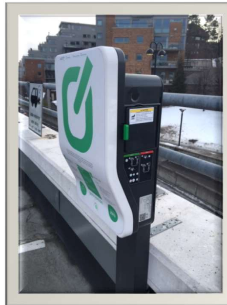
Ladestasjon (Schneider Evlink Wallbox type)
