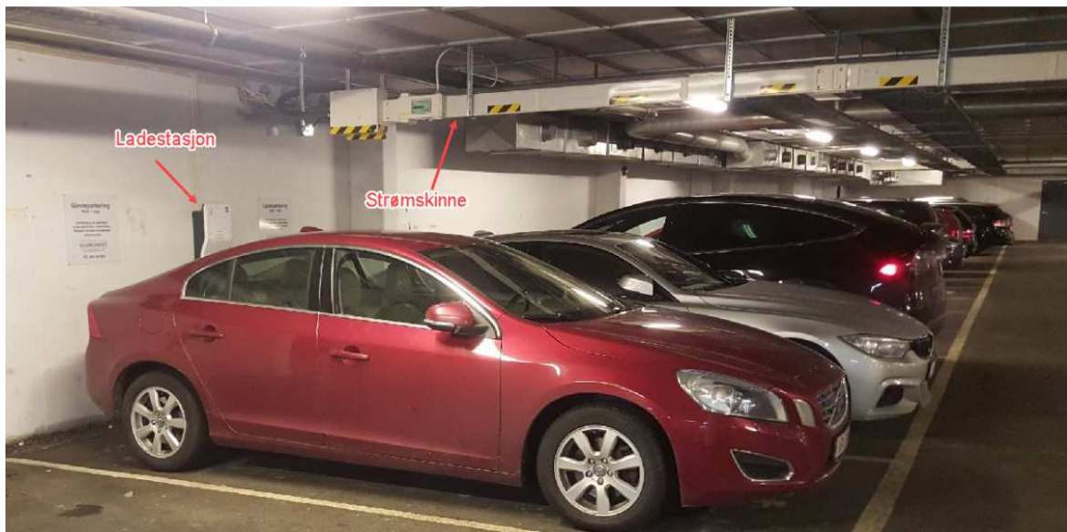
Figur 2: Eksempel på strømskinne montert i et annet garasjeanlegg
