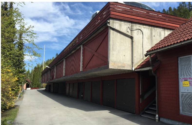
Fig. 1: Fellesgarasjen i Linderudveien
