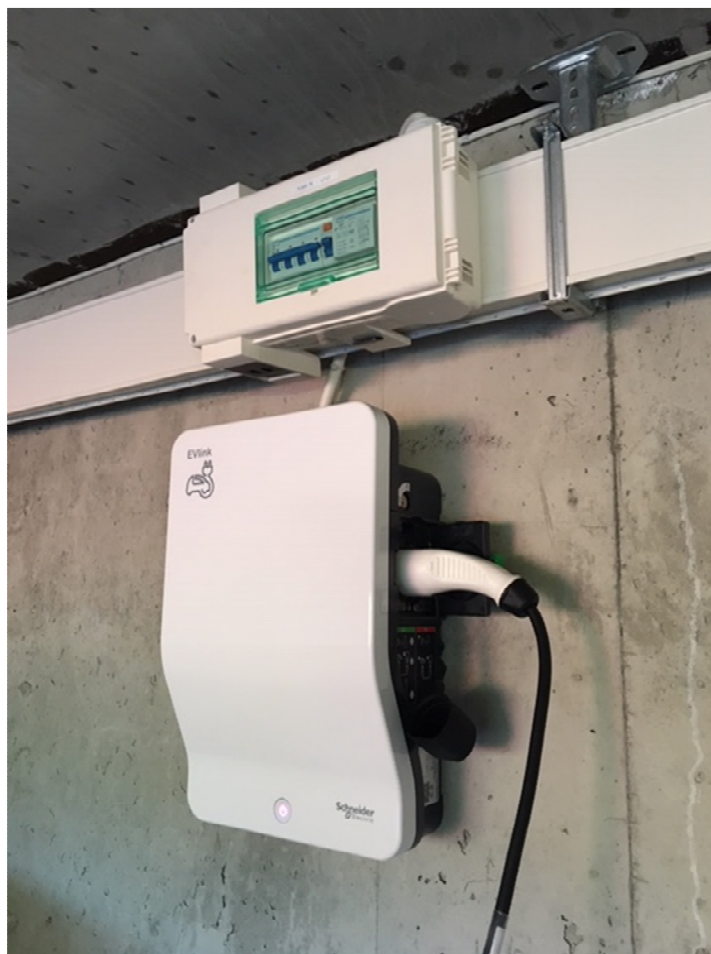
Figur 4: Type 2 uttak fra ladestasjon, med tilkoblet type 2 kabel (kabel følger ikke med ladestasjon, men følger normalt med bil)
