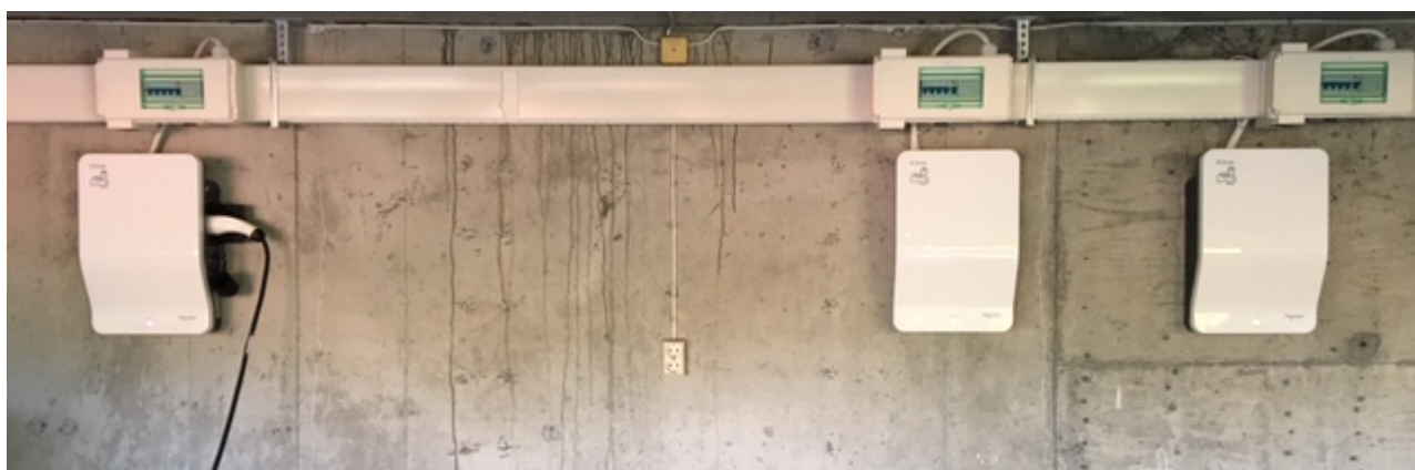
Figur 2: Strømskinne med avtappingsbokser og tilkoblede ladestasjoner
